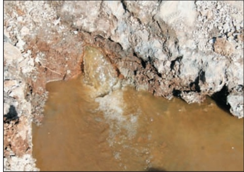
b. Austritt des gefärbten Wassers an mehreren Stellen im Bereich der Baustelle.
